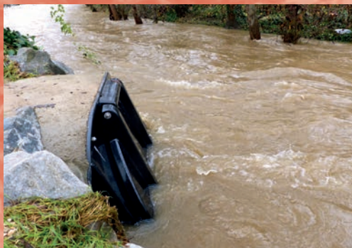
Chemin du rivage - Brignais / exutoire eaux pluviales Garon / SMAGGA ©
