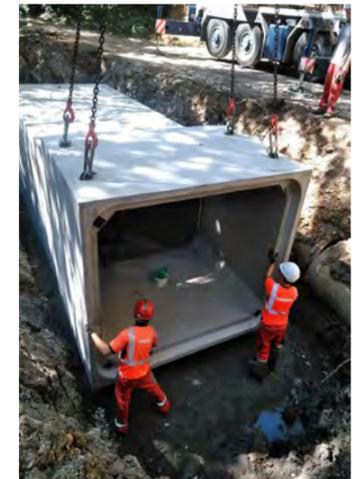
Améliorer le fonctionnement hydraulique des cours d'eau, comme ici sur le Merdanson de Chaponost, passe par la suppression des ouvrages sous dimensionnés occasionnant des inondations.
