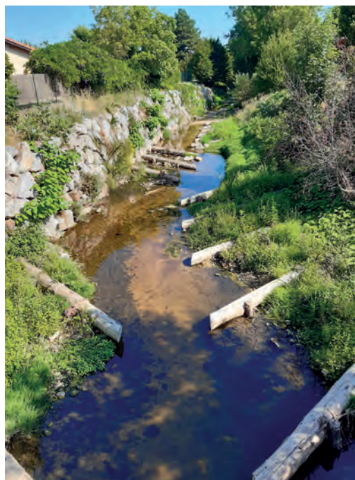
La pose de rondins de bois en épis permet de réduire la section d'écoulement de la rivière et d'aider la faune aquatique à mieux traverser les périodes d'étiage.
