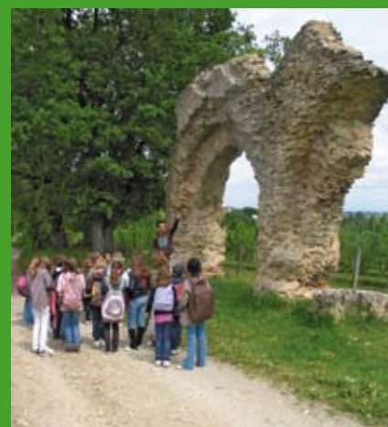
A Soucieu-en-Jarrest, l'aqueduc du Gier donne au paysage des airs de dromadaire.
