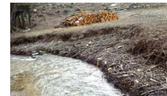
Réalisation d'un peigne à la confluence du Garon et de l'Artilla à Thurins. Cette technique consiste à accumuler et à fixer entre deux lignes de pieux des ligneux dont l'effet est de dissiper la force d'arrachage du courant.
