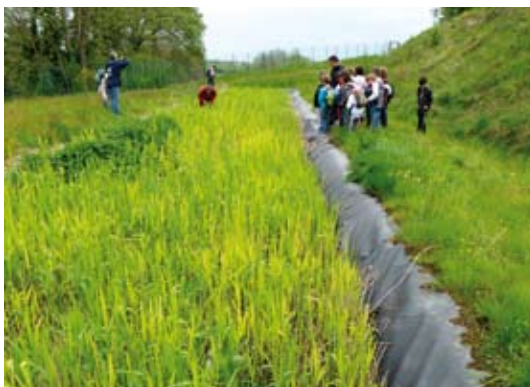
Afin de restituer au milieu des eaux propres, 6 stations d'épuration devraient voir le jour d'ici 5 ans. Elles permettront de lutter efficacement contre les pollutions des rivières par le phosphore. Pour les hameaux isolés du réseau d'assainissement collectif - comme ici au hameau de La Plaine à Mornant - la technique de station à filtres plantés de roseaux sera privilégiée.
