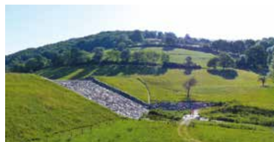
D'une hauteur de 16,7 mètres sur 180 mètres de longueur, l'ouvrage de Sorbiers a une capacité de stockage de près de 400 000 m 3 .
