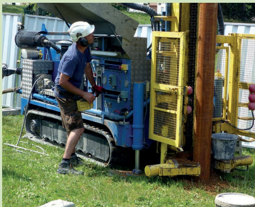
Carottage en vue de la pose d'un piézomètre permettant de mesurer le niveau de la nappe.
