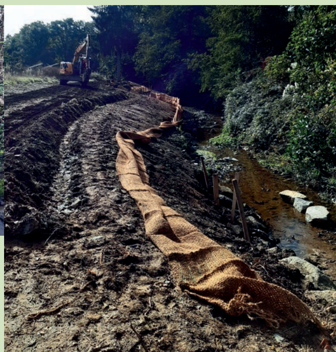
Etat d'avancement des travaux sur le Mornantet. La ripisylve sera dorénavant plus diversifiée et mieux adaptée aux milieux aquatiques. Photos : état initial à gauche, pendant les travaux de restauration de la berge à droite.
