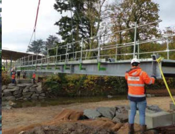
La dernière tranche de travaux de protections contre les crues locales du Garon à hauteur du complexe sportif Pierre Minssieux s'est achevée avec une restauration écologique et hydraulique du lit du Garon (photo à gauche) et la pose d'une passerelle plus longue enjambant la rivière (photo ci-dessus). En vignette, l'état de la berge avant les travaux.
