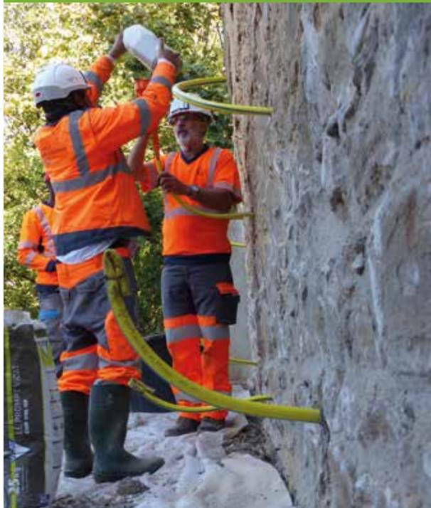
A Brignais, chemin du rivage, un mur d'enceinte participant à la protection contre les crues a été stabilisé et étanchéifié.
